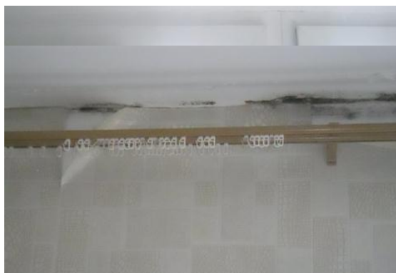
Рис. 1. Плесень на внутренних поверхностях ограждающих конструкций
