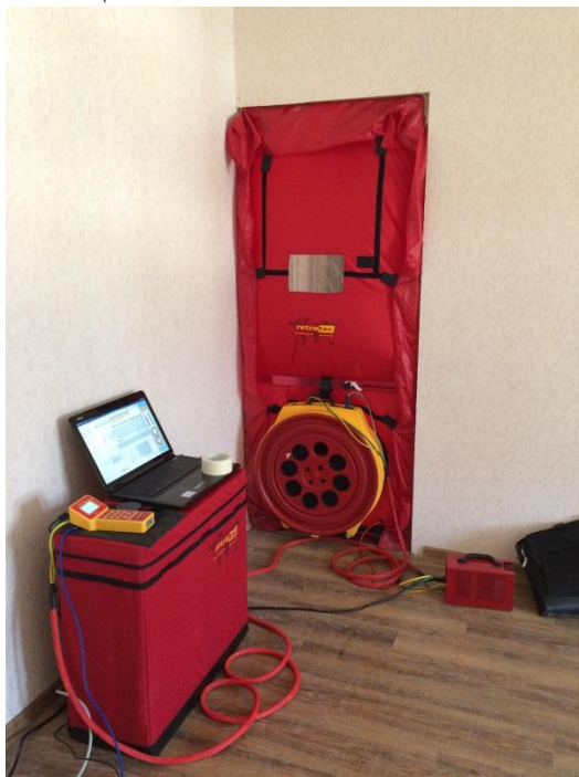
Рис. 2. Испытательная установка в дверном проеме
